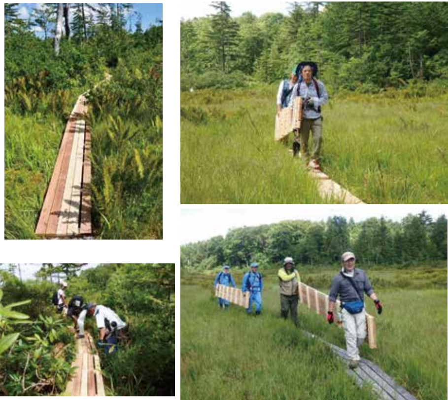
水無谷地 50枚のスノコを運搬、整備 白樺谷地 19枚 大工さんが固定した 6~7調査 17日運搬準備 18日湿原内作業
